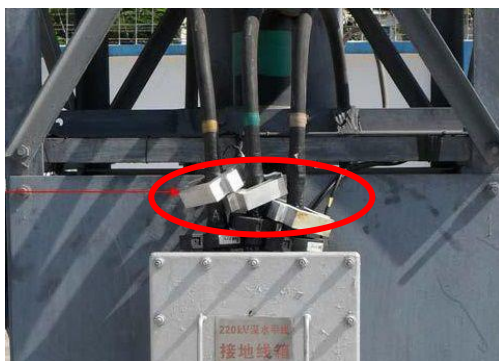
高频电流传感器现场安装图
